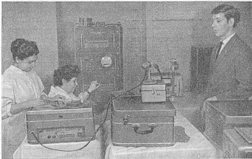
Рис. 24. Запись на магнитофонной ленте певческого голоса для спектрального анализа.
